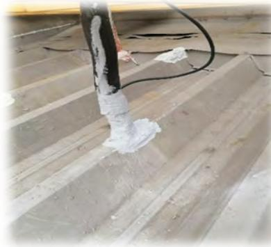
Instalación de filtro en entrada de tanque de captación en el edificio central del ICT, con el fin de evitar la
